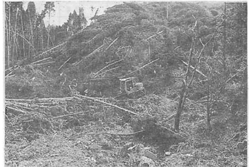
写真-1 ハーベスタによる復旧作業
