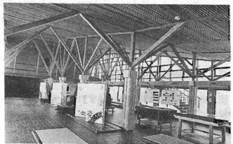
写真-2 木造トラス構造の実施例
