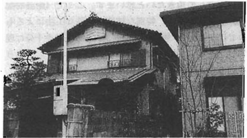
写真-2 無被害の在来軸組構法木造住宅(西宮市)
