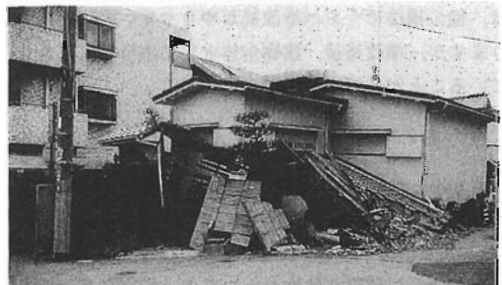
写真-3 1階部分が完全に崩壊した住宅(西宮市)
