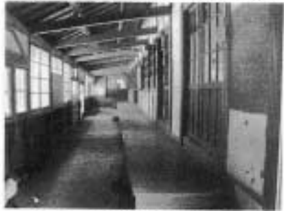
写真-3 岐部小学校 北校舎 廊下
