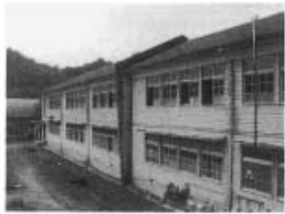
写真-7 三郷小学校外観(昭和38年築)
