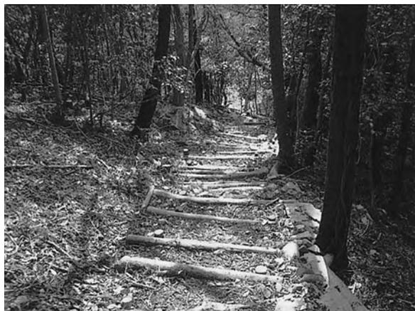
遊歩道の施工にあたっては、全ての施工材料を現場で発生した石材・木材を用い、外部からの材料の持ちこみや外部への持ち出しは行わない
