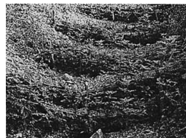
a. Live check dam
