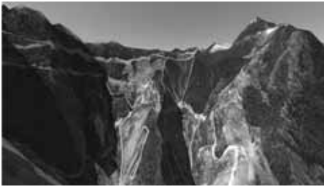
図-2. 被害地の立体写真
