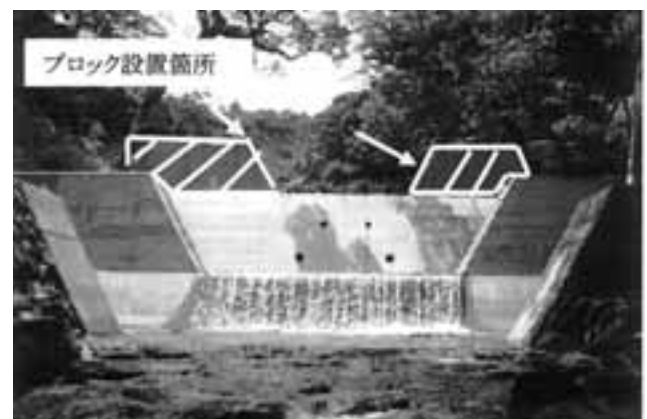
写真-1. 調査地の様子(斜線部がブロック設置箇所)
