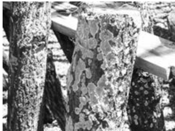
写真-2 背着性の子座を作るヒポクレアによる被害木 (大分県豊後大野市)
