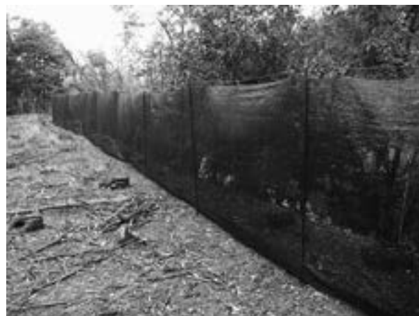
写真-1. 遮光ネットの施工例
