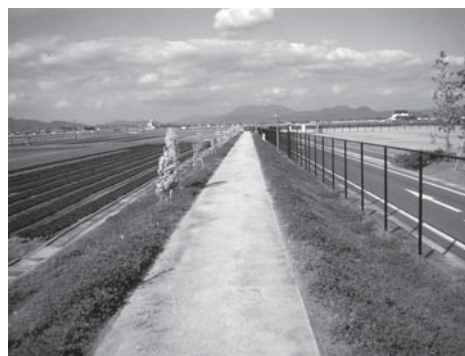
図-5 竹利用の土舗装(久留米市(福岡県))
