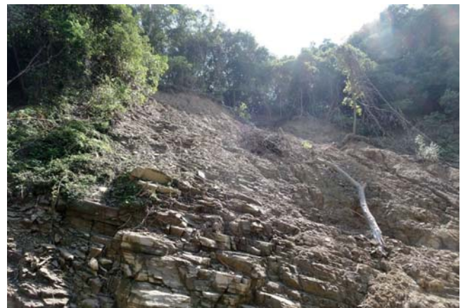
写真-4. 変成岩の崩壊地(福岡県朝倉市)
