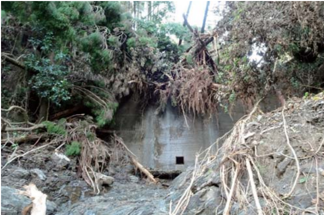
写真－11. 治山ダムによる流木の捕捉状況
