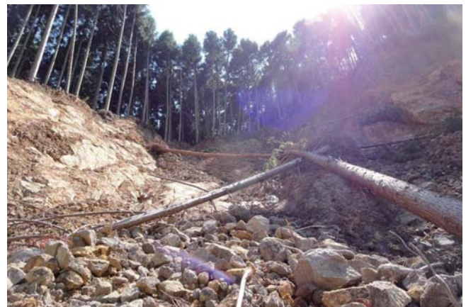
写真-5. 安山岩の崩壊地(大分県日田市)
