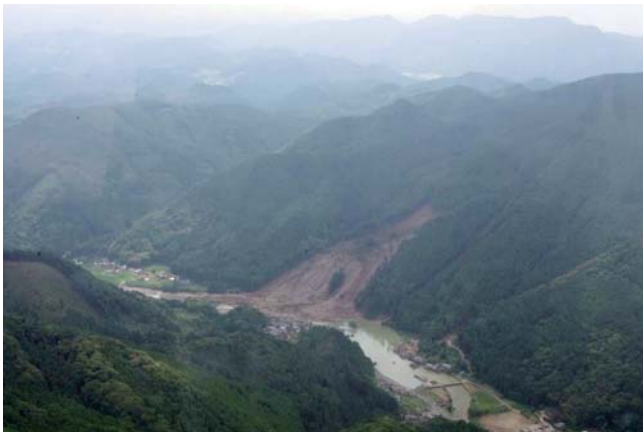
写真-2. 大分県日田市で発生した山腹崩壊
