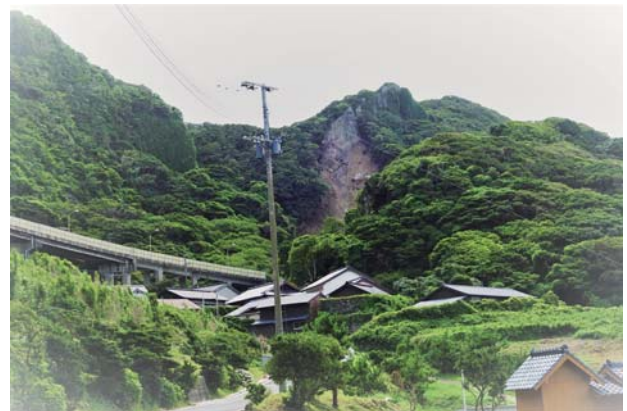
写真-4. 長崎県平戸市主師町で発生した山腹崩壊
