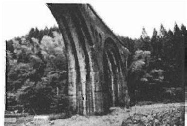
写真-3 竹筋コンクリートを使用した旧鉄道橋 (熊本県阿蘇郡小国町)
